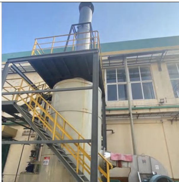
硫酸镍干燥废气处理设施
